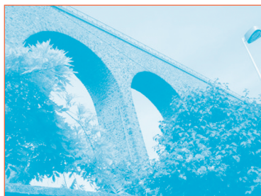
Le pont-aqueduc de la Vanne à Arcueil
